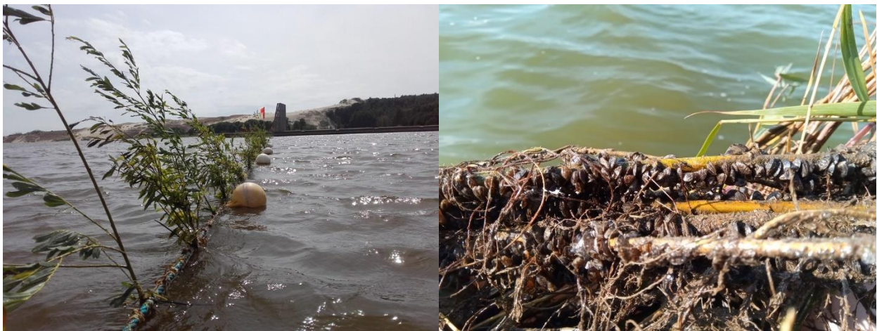
1.1.3.6 pav. Plūduriuojančio barjero instaliacija ir prie karklų kamienų prisitvirtinusios dreisenos (Ž. Grigaičio nuotraukos).
