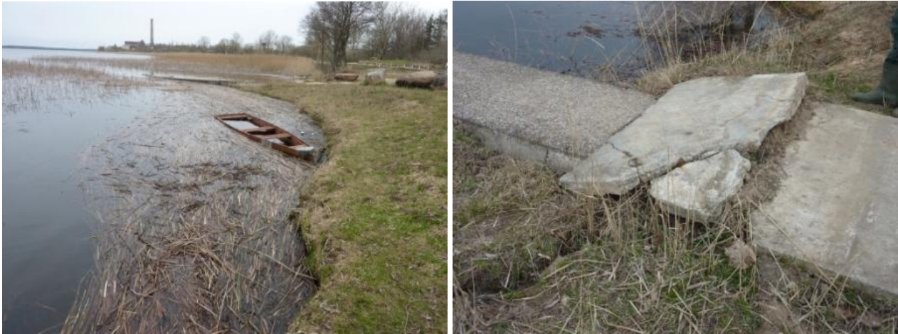
2.2.9 pav. Mineralinio grunto krantai, betoninis lieptas per kelis metus ledo pastumti apie 2–3 m (A. Balevičiaus nuotr.)
