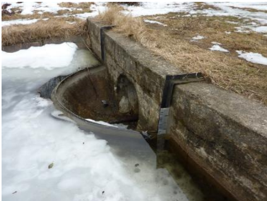
2.2.7 pav. Iš Rėkyvos ištekančio vandens pralaida – vandens lygio matuoklė (A. Ciūnio nuotr.)
