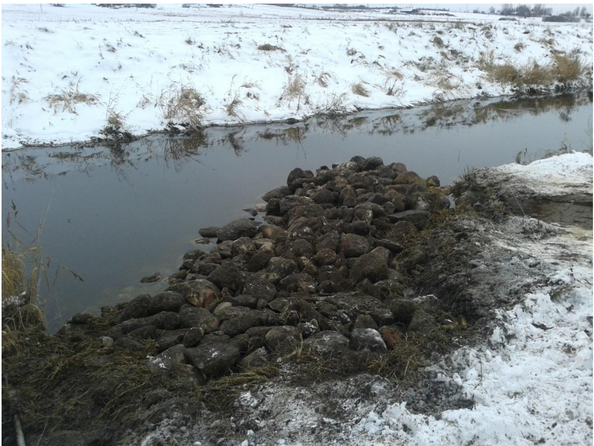
2.16 pav. Akmenų metinio (būnos) kliūties bendras vaizdas Vyžuonos upėje 2016 m. lapkričio 10 d.
