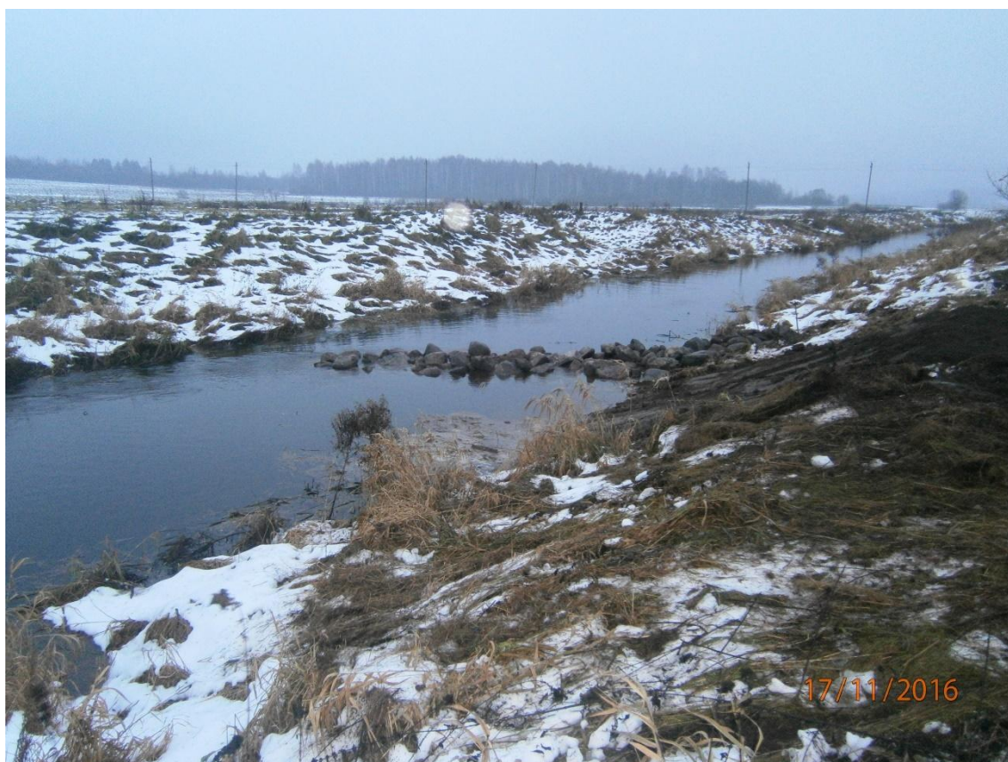
2.18 pav. Akmenų metinio (būnos) kliūtis Vyžuonos upėje 2016 m. lapkričio 17 d.
