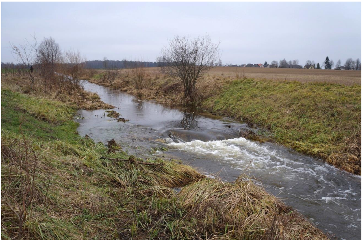
2.10 pav. Rąsto ir akmenų metinio kliūtis-slenkstis Vašuokos upėje 2016 m. lapkričio 23 d.
