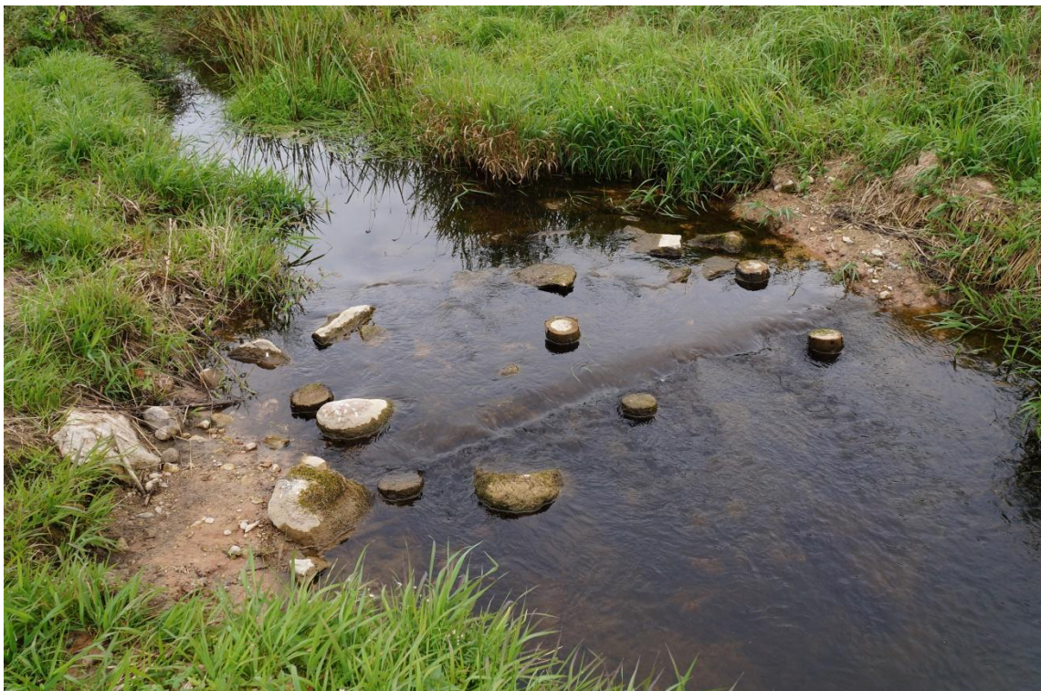
2.8 pav. Rašto ir akmenų metinio kliūtis-slenkstis Vašuokos upėje 2016 m. rugsėjo 19 d.
