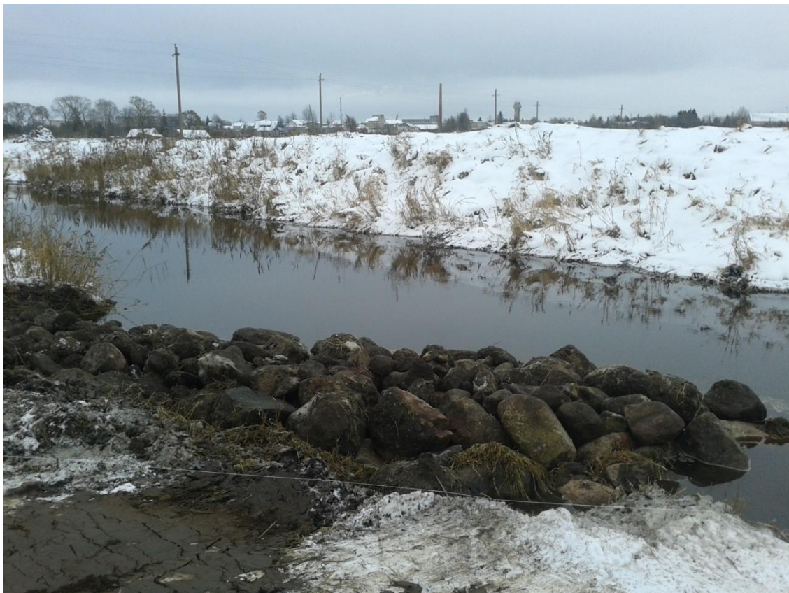
2.17 pav. Akmenų metinio (būnos) kliūtis Vyžuonos upėje 2016 m. lapkričio 10 d.
